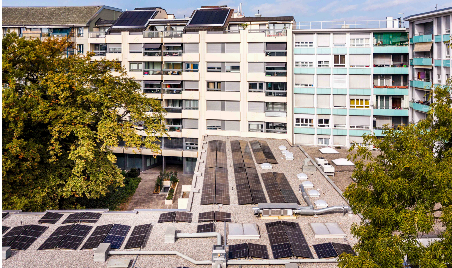
Panneaux photovoltaïques et solaires thermiques en toiture
